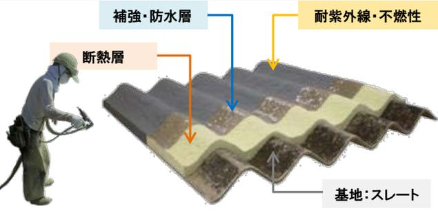
スレート屋根や折板屋根の素地に対し、「ポリウレタン断熱層」「ポリウレタン補強防水層」、「耐紫外線・不燃性トップコート層」の3層を順次吹き付ける。これにより、一度に「防水・補強・断熱」が可能になる。また、瞬間硬化型フォームを使用しており、大面積への施工、工期短縮が可能となり大幅なコストダウンを実現する。その他、防音・結露防止等の効果も得られる。
