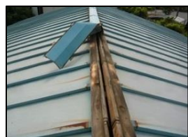
棟取り直し工事
