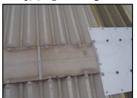
雨漏り対策・ 防水工事
