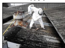
屋根・雨樋 清掃
