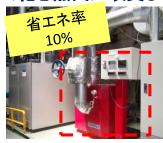
従来の貫流式ボイラは、乾き 度が低い湿り蒸気を生成させ、 配管中に多くのドレンを生じさせ ている。そこでボイラとヘッダー の間にサイクロン式蒸気改質 装置を設置。
